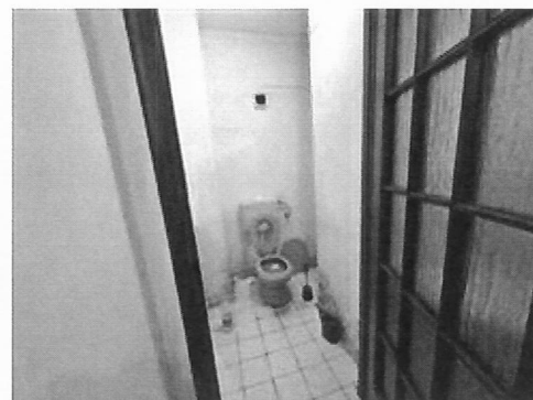
Dettaglio del wc al piano seminterrato
