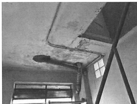
Dettaglio del soffitto nel piano seminterrato
